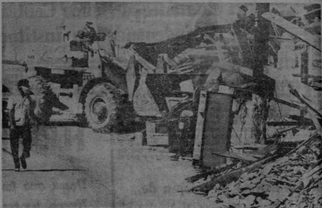
DESPEJAN LAS CALLES. Un cargador trabaja en la devastada Managua para despejar el área de escombros. Debido al mal olor y al polvo los que trabajan en esa área tienen que utilizar mascarillas protectoras que dificultan un tanto la respiración debido al intenso calor. (AP).
